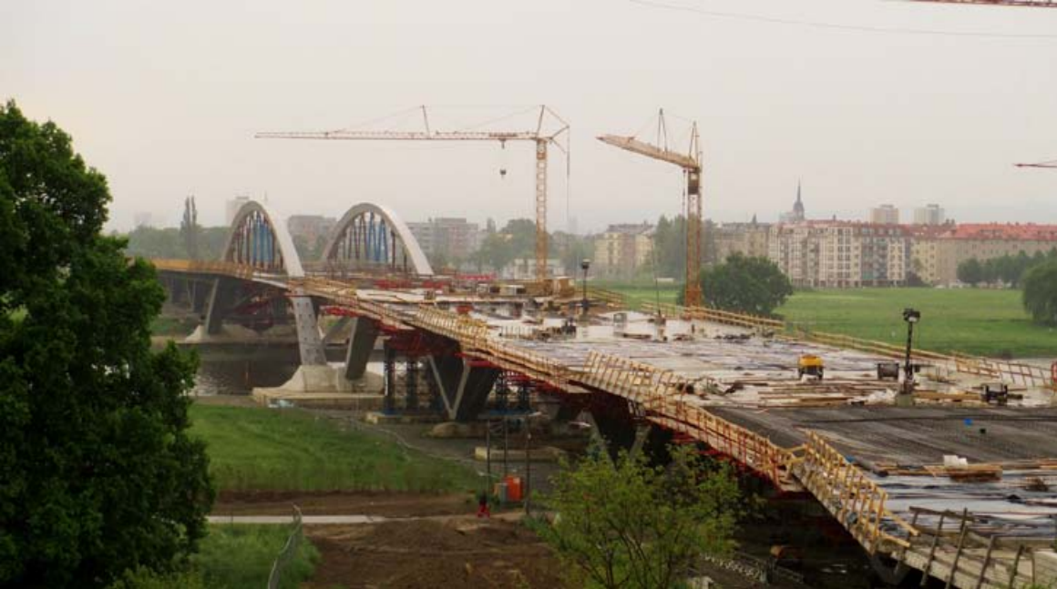
Construcción del puente Waldschlößchen, por el cual UNESCO revocó el nombramiento/ The construction of Waldschlößchen Bridge caused the revocation of the designation of Dresden as a World Heritage Site
